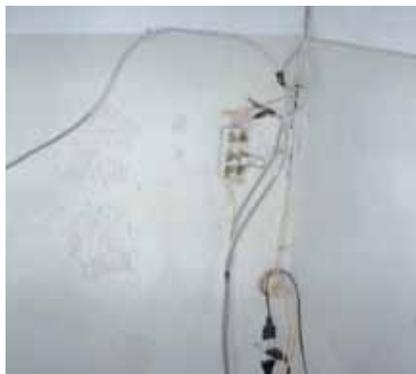
Fiação exposta, com emendas, além de instalação sobrecarregada
