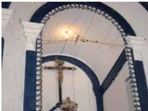
Fiação exposta, com emendas, instalada diretamente no elementos de madeira
