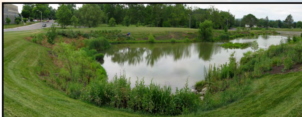
Figura 10 – Fotografia de um depósito superficial de retenção (Fonte: Internet) 26
