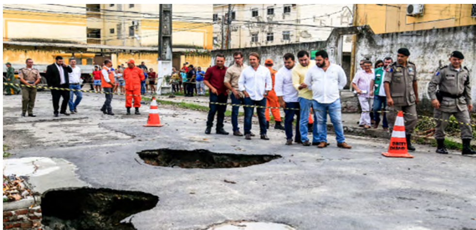
Figura 3 – Uma das ruas afetadas pelo afundamento do solo na região
