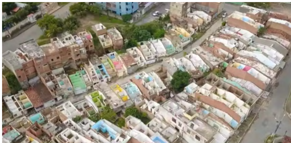
Figura 1 – Casas abandonadas em virtude dos riscos do local.
