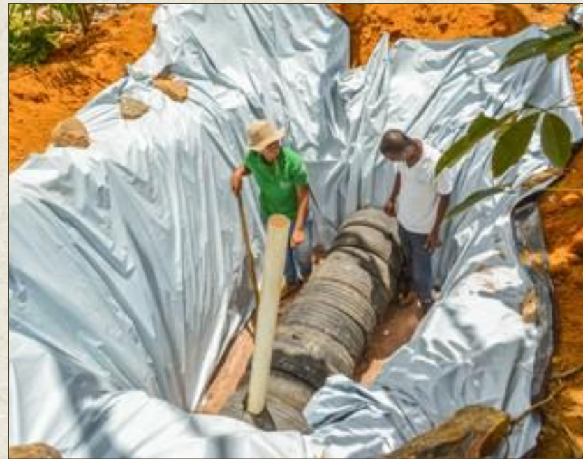
Construção de Fossa Séptica Econômica
